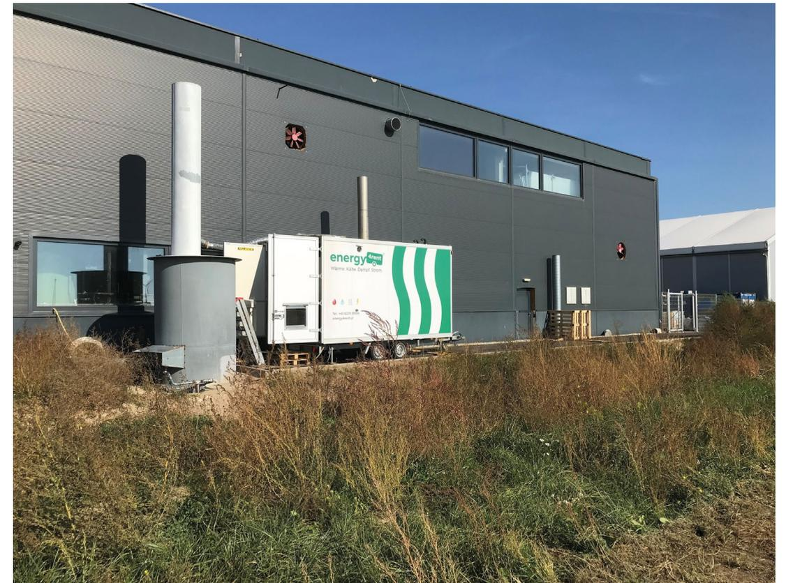
Der mit Strom betriebene Dampfkessel wurde mit einem ölbetriebenen energyMobil Dampf mit 700 kg/h abgesichert
