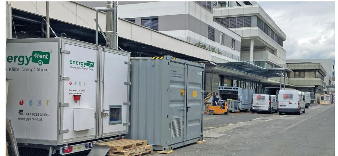
Während der Sanierungsarbeiten versorgte ein TÜV geprüftes gasbetriebenes energyMOBIL Dampf das Landeskrankenhaus Villach
