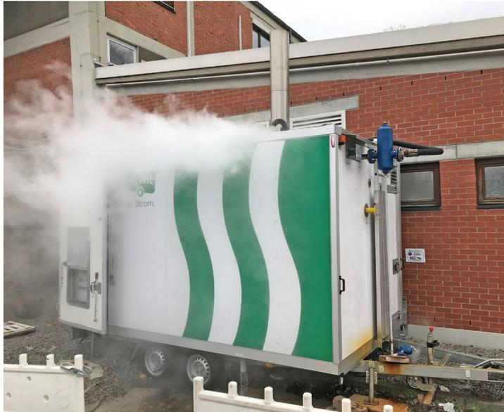
100% abgesicherte Impfstoffproduktion mit einem energyMOBIL Dampf 700 kg/h und zusätzlichem Redundanzkessel
