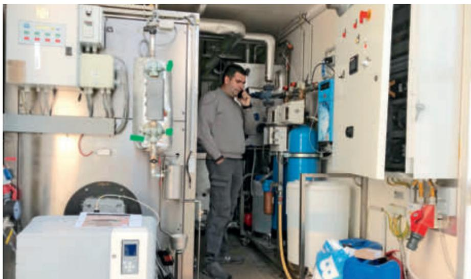
Der TÜV-geprüfte mobile Dampfkessel von energy4rent mit 700 kg/h hat die Wasseraufbereitung und eine BoB bereits inkludiert.
