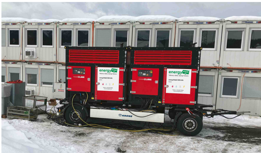
Das energyMOBIL Strom lieferte 1.000 kVA bei einem Baustellen Blackout.
