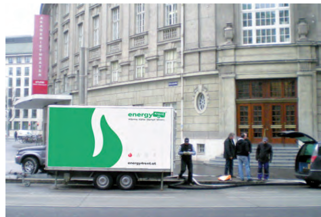
Temporäre Bühnenbeheizung des Wiener Akademietheaters.
