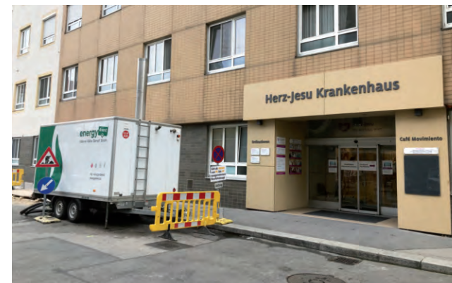
Mobile Wärmebereitstellung wegen Fernwärmeabschaltung auf Grund von Wartungsarbeiten.
