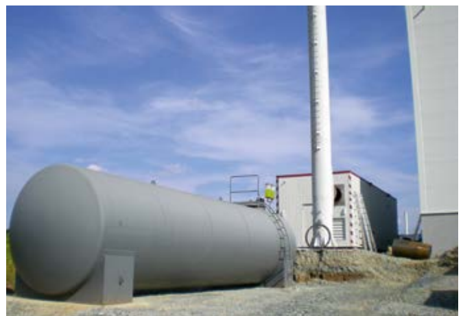
Überbrückung der nicht fertig gestellten Fernwärme in Güssing
