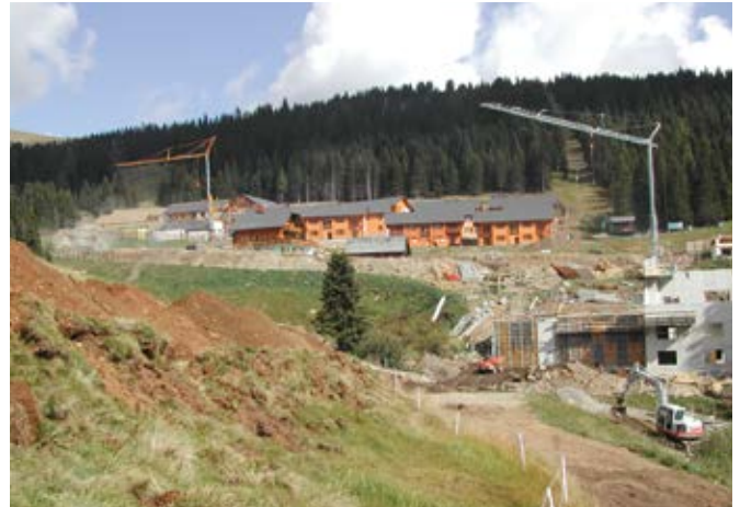
Baustelle im Feriendorf Schönberg-Lachtal
